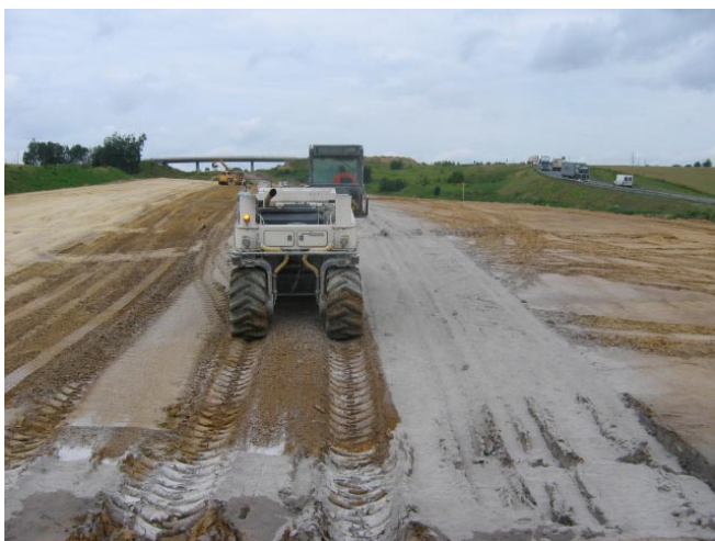
Stavba rychlostní silnice R6 s použitím VEP
